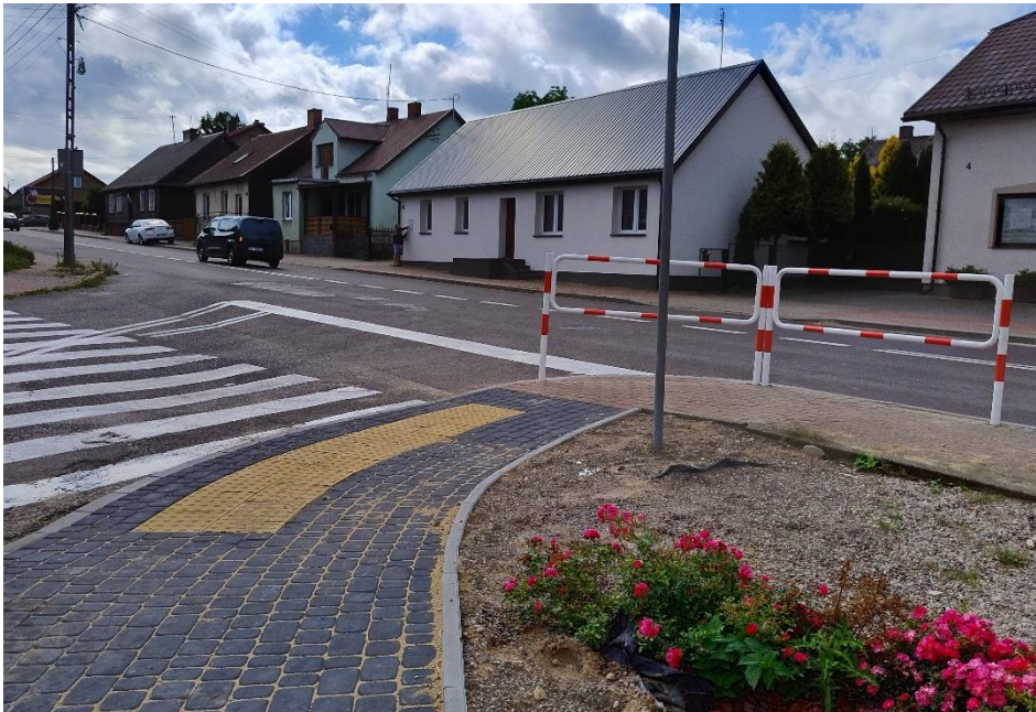
Zdjęcie 3 Remont chodnika na ul. Sikorskiego w Sokołach
