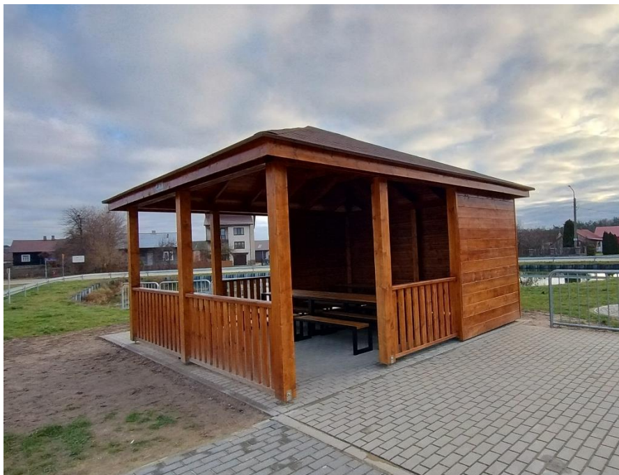
Zdjęcie 2 Wybudowana wiat przystankowa w miejscowości Czajki
